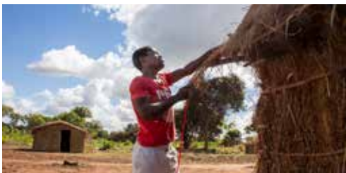
Para reconstruir sus hogares, las familias están construyendo marcos y techos sencillos, utilizando herramientas y lonas proporcionadas por CRS, así como materiales recuperados y disponibles de forma natural. Foto de Dooshima Tsee/CRS
