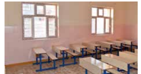
CRS renovó esta escuela dañada en las llanuras de Ninive. Foto de Fadi Salam Iliya para CRS
