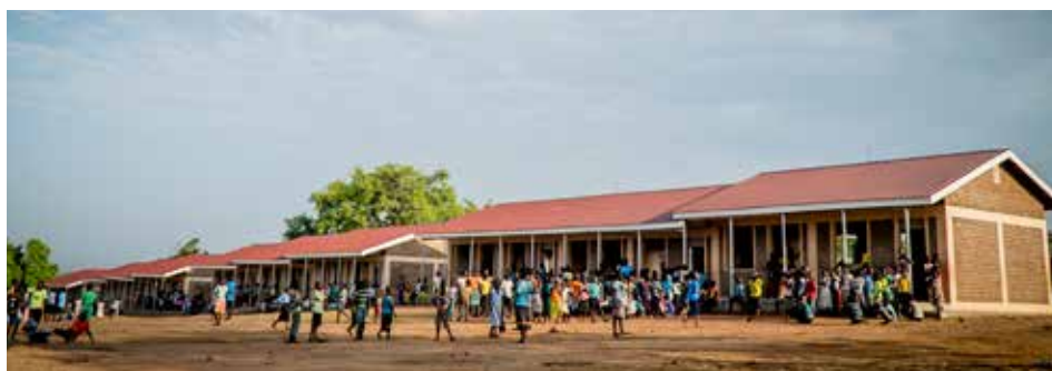
Antes de que CRS construyera estas nuevas aulas en la escuela primaria Ayivu en el asentamiento de refugiados Bidi Bidi, los alumnos competían por el espacio del aula y la sombra en estructuras de aula deterioradas. Foto de Karin Bridger para CRS
